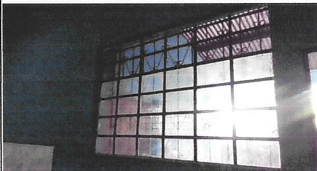
Foto 8: Instalacion de ventanas PVC
