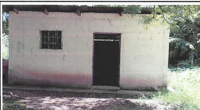
Foto 5: Restauracion de techo de cocina.
