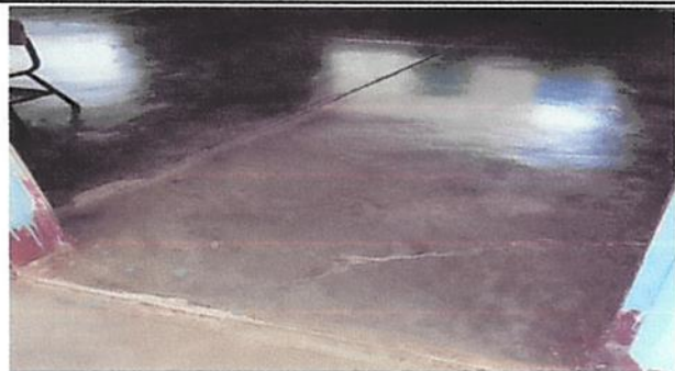
Foto1: Mejorar base de piso actual e instalación de piso ceramico.
