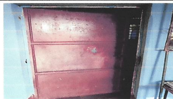
Foto 6: Rstauration de puertas de aulas
