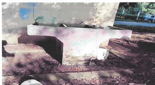
Foto 7: Instalación de pila de dos lavaderos
